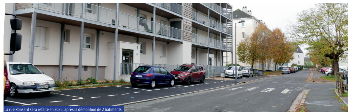
La rue Ronsard sera refaite en 2026, après la démolition de 2 bâtiments
