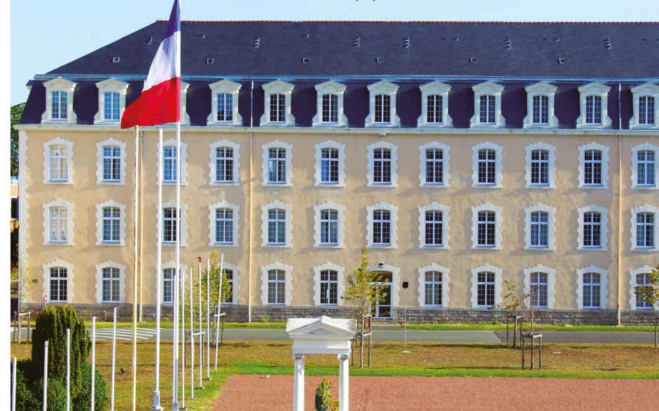
ANGERS (49) - Caserne Éblé - Bât.003 - Réfection toiture et lucarnes
